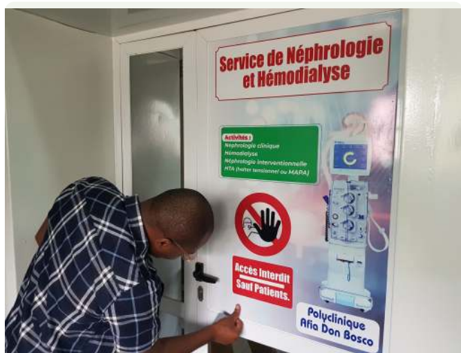
Pose de signalétique sur porte
